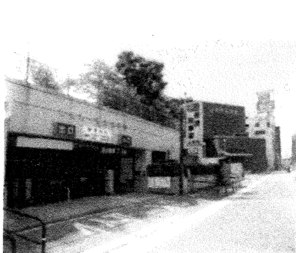
香澄駐車場 出入口
